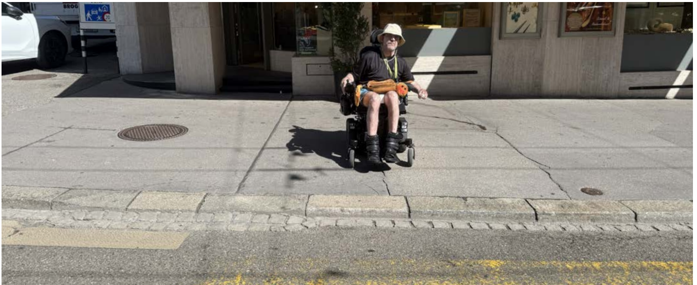
Die Trottoirauffahrt beginnt da, wo der Fussgängerstreifen endet. Dafür ist der Absatz bestens ertastbar.
