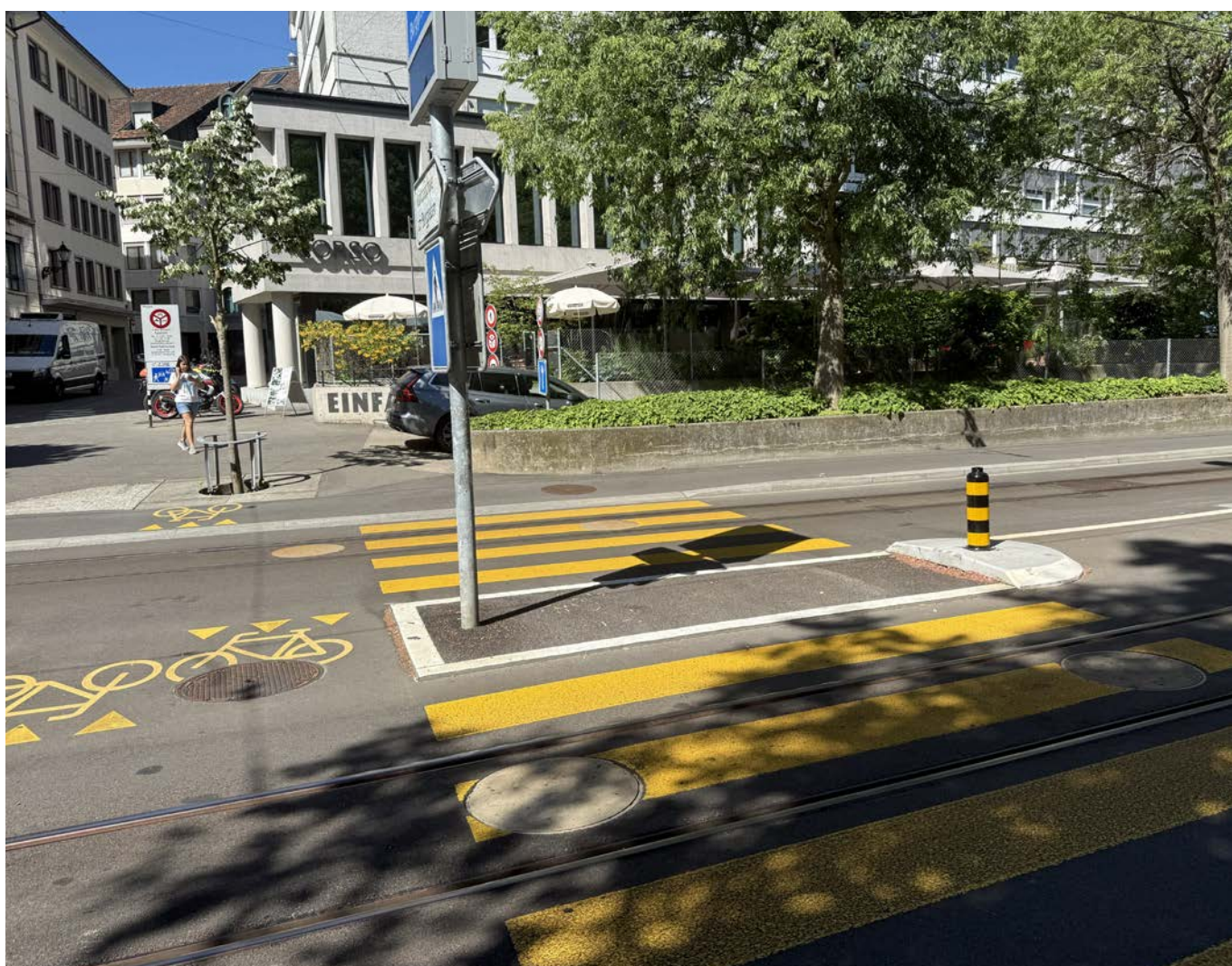
Am Burggraben sehen wir noch eine Variante, bei der Blinde und Sehbehinderte im Bereich des Fussgängerstreifens Anschläge vorfinden. Rollstuhlfahrende können auf der Velospur die Strasse queren.
