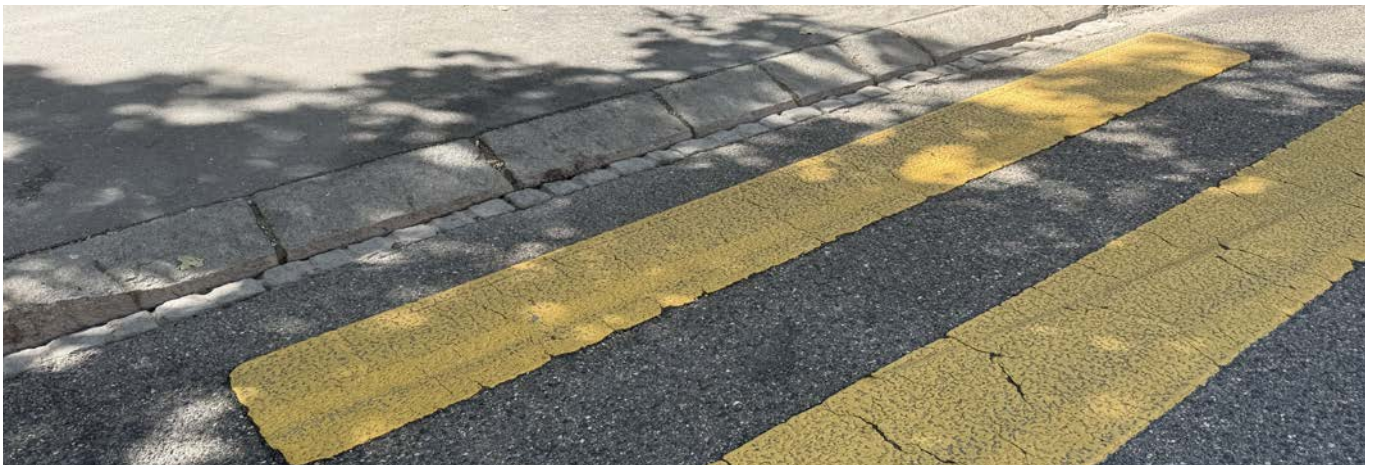
Heute wäre es wohl eine durchgehende Absenkung und keine Rampe. Aber laut Lukas Schällibaum funktioniert das sowohl mit dem Rollstuhl als auch mit dem Blindenstock.
