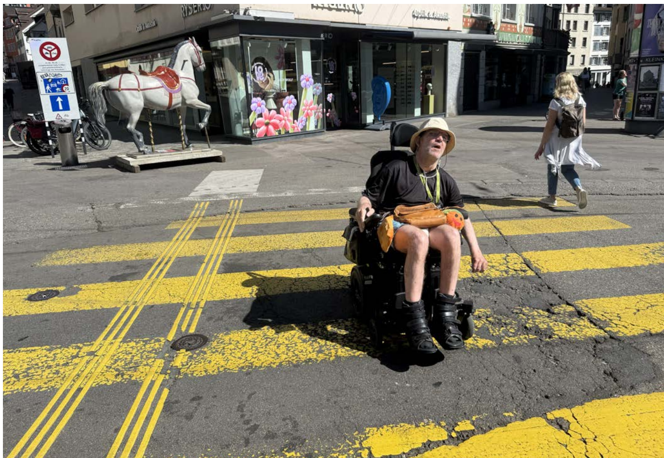
Übergang ohne Kante. Aber wenigstens hat es ein Aufmerksamkeitsfeld und eine Blindenleitlinie von der einen Strassenseite...
